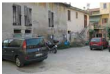
Prima della demolizione
