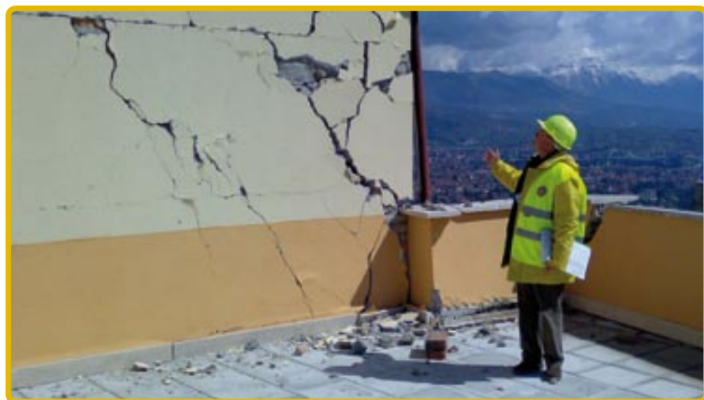
● L'Aquila 25 aprile 2009. L'ing. Marchegiani in ricognizione per verificare l'agibilità di stabili pubblici e abitazioni private (Foto Archivio Comunale)
