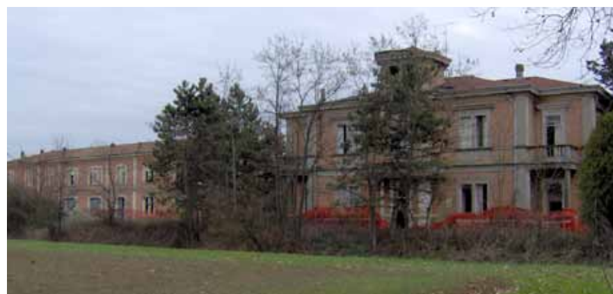
● L'edificio principale della ex polveriera
